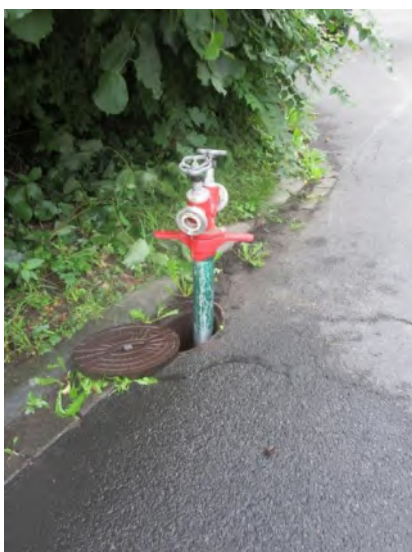
Für Feuerwehrbedarf wird hier ein mobiler Hydrant eingebaut
