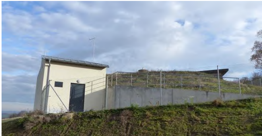
Der Hochbehälter III nach seiner Fertigstellung
