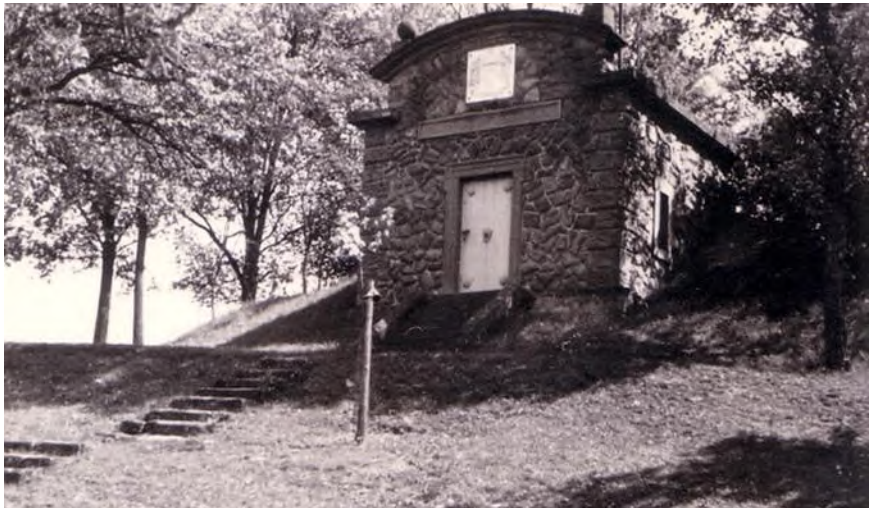
Hochbehälter I (Foto Karl Michael Fischer)
