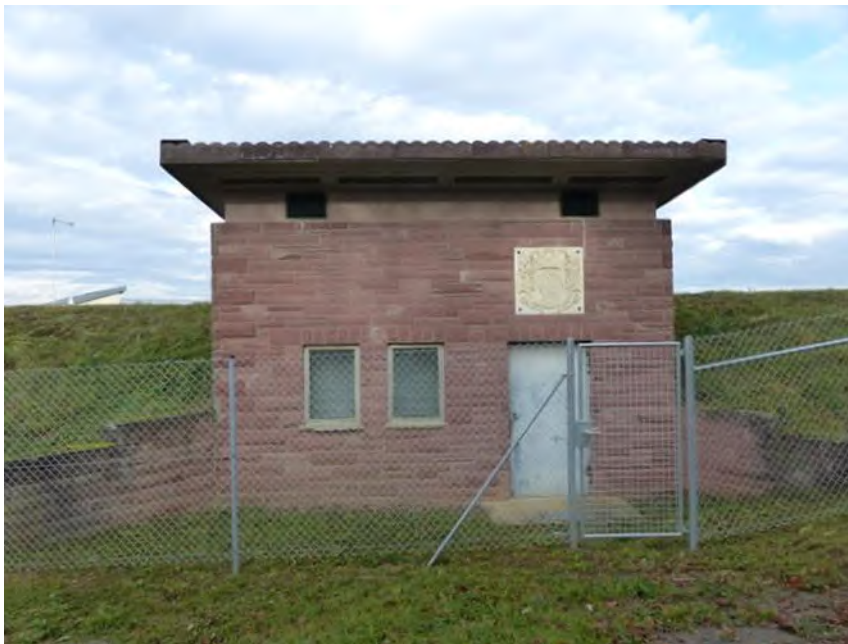
Der Hochbehälter II wird geplant
