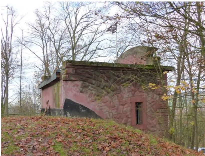
Der Hochbehälter I von Norden gesehen
