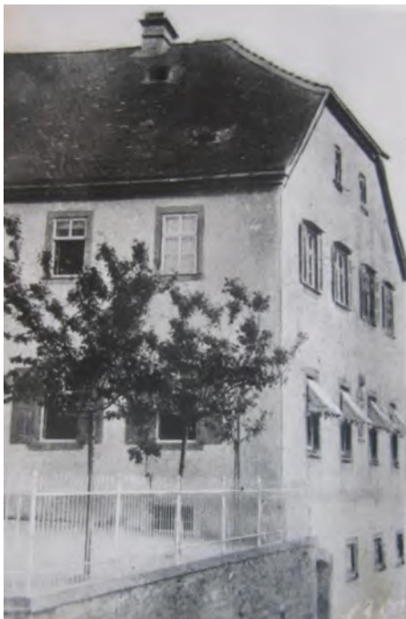
Auch die Präparandenschule wollte und sollte mit fließendem Wasser versorgt werden (Foto Michael Fischer)
