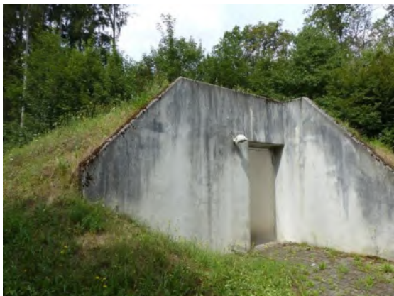
Eingang zum Brunnenschacht
