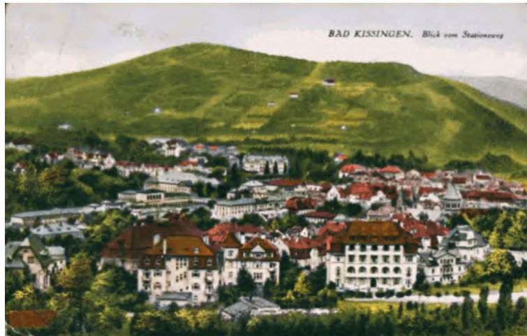
Bad Kissingen wurde als Referenz für eine ordentliche Wasserversorgung empfohlen
