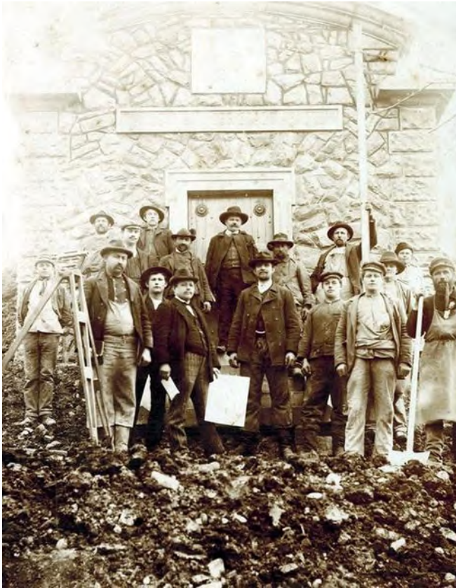
Die am Bau beteiligten Arbeiter vor dem Hochbehälter I. Ganz schwach ist das schöne Wappen oben zu sehen. Leider sind die Namen der Beteiligten nicht erhalten.
