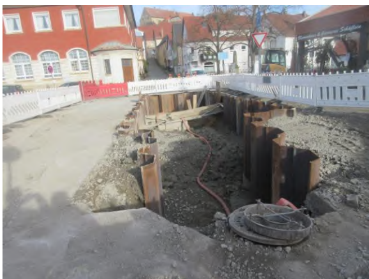
Bauarbeiten 2020 in der Grabenstraße
