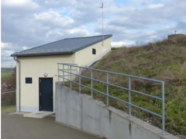
Im April 2016 wurde mit dem Bau des Hochbehälters III begonnen
