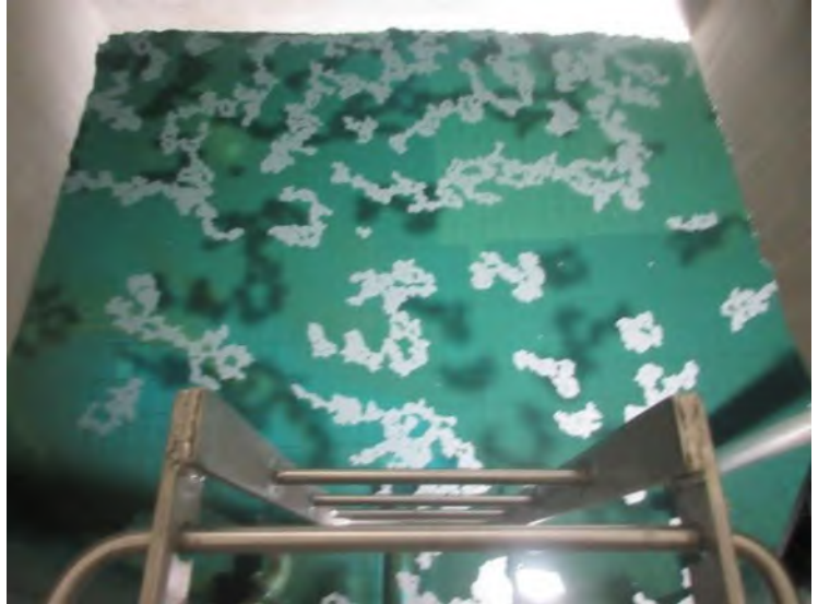
Hier sieht man klare Kalkflecken auf dem Wasser im Hochbehälter in Gauaschach
