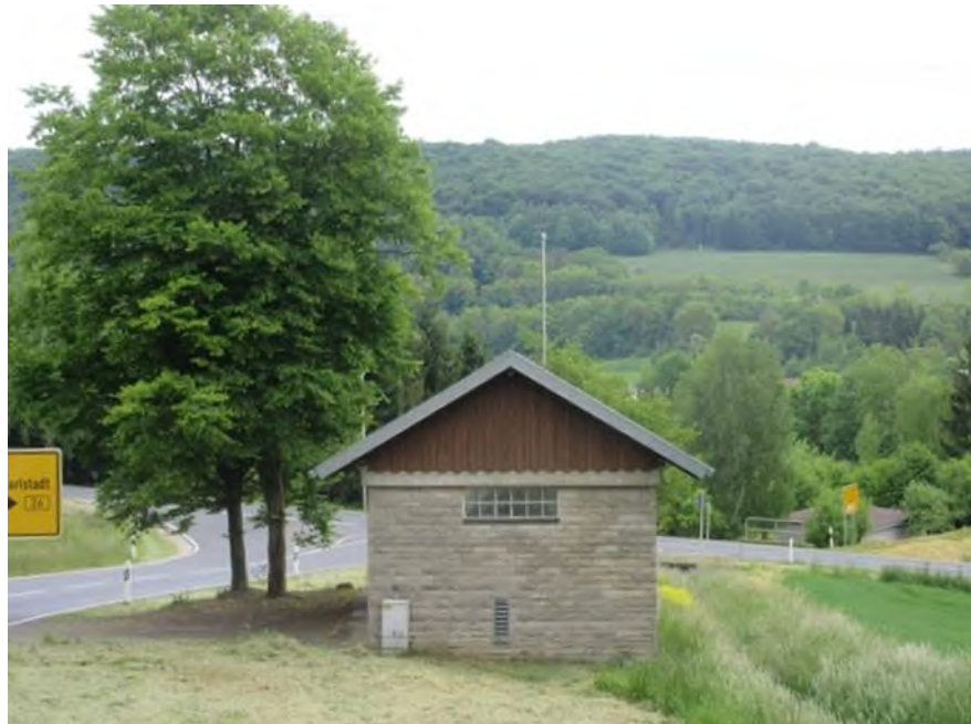
Pumpstation für Dattensoll am Aussiedlerhof Weißenberger in Müdesheim
