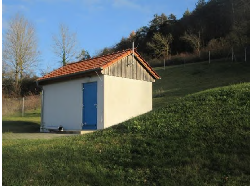
Brunnen III neben dem Radweg Müdesheim-Binsfeld
