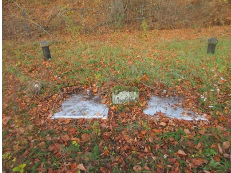
Hochbehälter in Heugrumbach oberhalb der Frankensteinstraße
