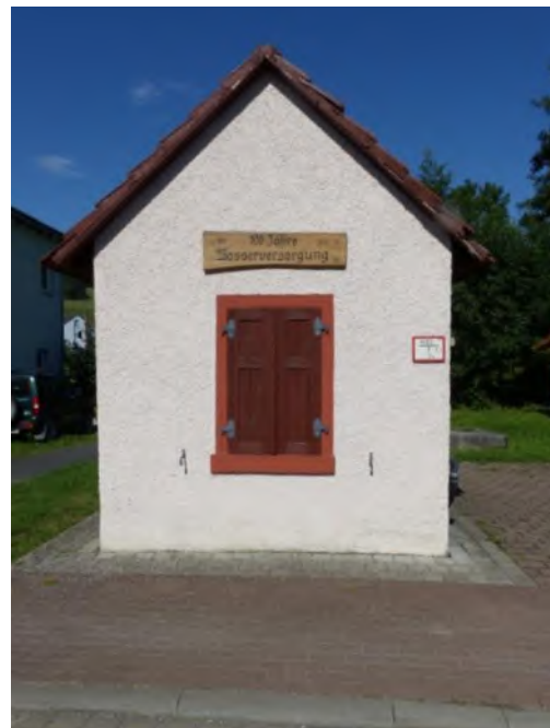
Bis sich die Hundsbacher Gruppe richtig entwickelte, war das kleine Wasserhäuschen am Ortsrand die zentrale Wasserversorgung
