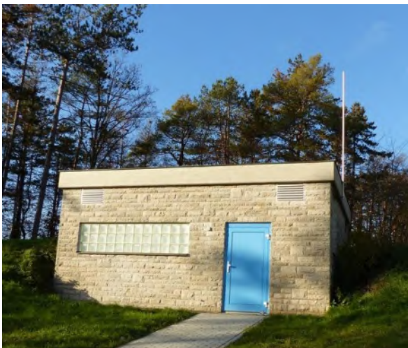
Hochbehälter in Halsheim
