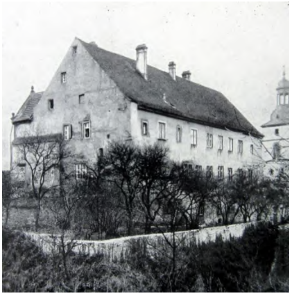
Der Amtsgerichtsrat, der in der Burg wohnte, beklagte sich über den nicht störungsfreien Wasserfluss
