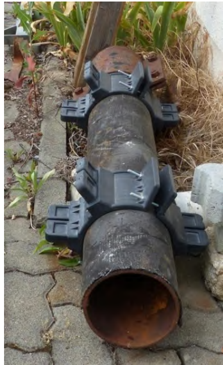
Ein altes Wasserrohr, wie es in Kaisten als Erinnerungsstück aufbewahrt wird
