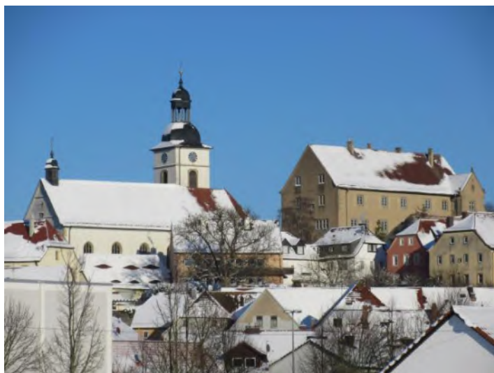
Besonders im Winter bei hohen Minusgraden froren schon manches Mal die Wasserleitung ein
