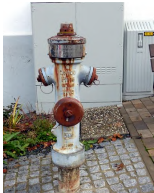
Johann Feser war auch zuständig für die Hydrantenplanung – hier am Schützenberg
