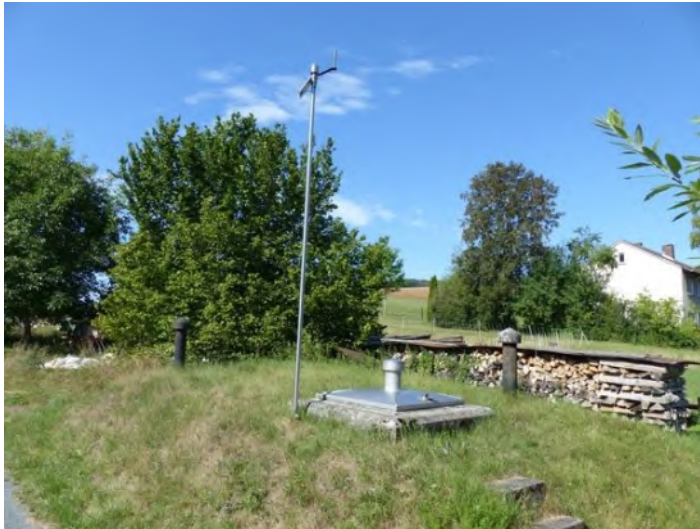
Weiterleitungsschacht in Obersfeld
