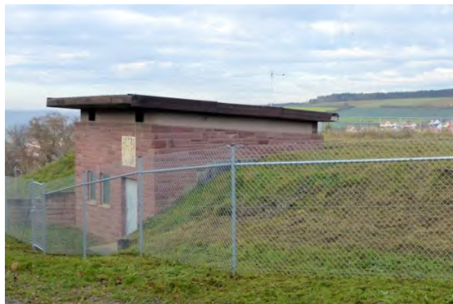
Der Hochbehälter II von Nord-Ost
