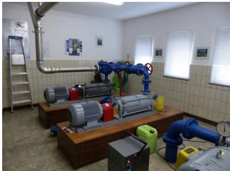
Inneres des Wasserwerks
