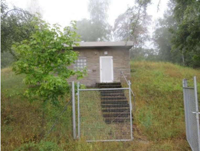
Wasserhochbehälter der Hundsbacher Gruppe in Gauaschach
