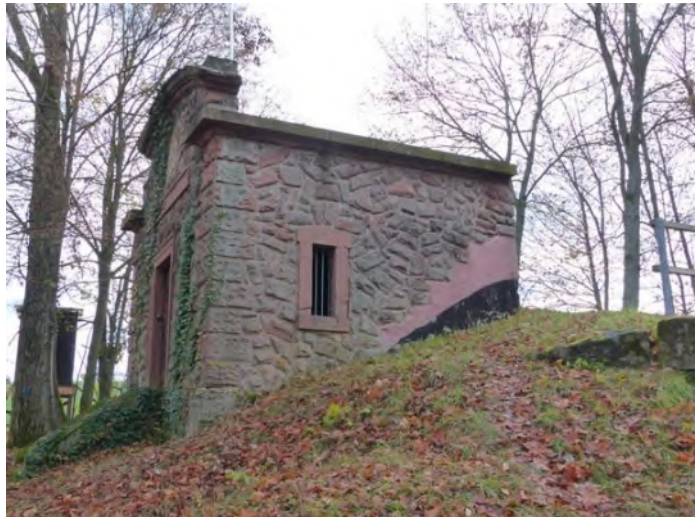
damals reichte ein kleiner Hochbehälter für die Wasserversorgung Arnsteins
